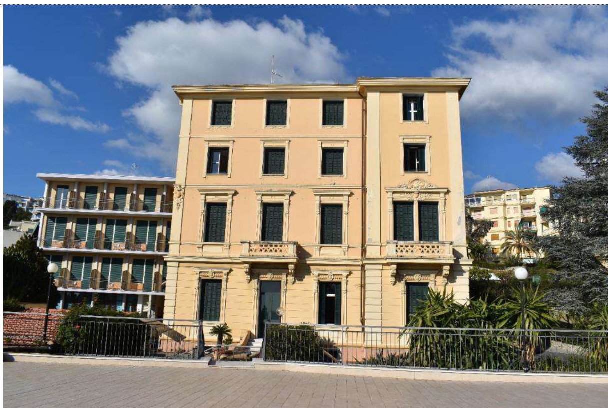
Prospetto Sud come si presenta oggi dopo la sopraelevazione
