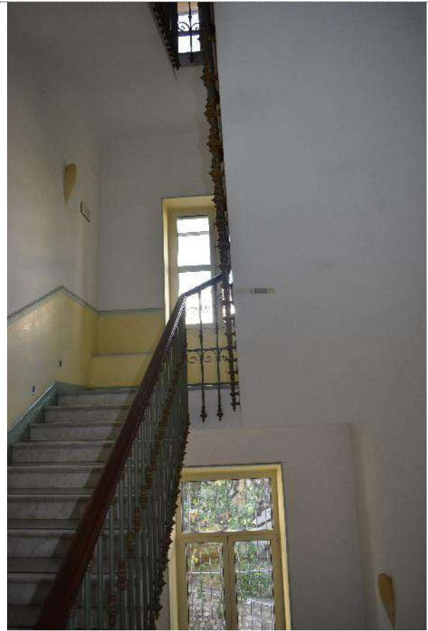
Particolare del vano scale: terza e quarta rampa
