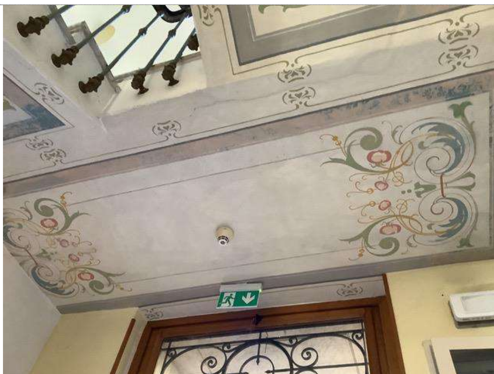
Particolare del sottoscala in corrispondenza della porta di servizio a nord
