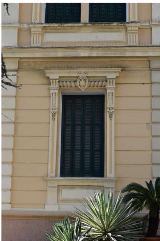
Prospetto Est: particolare della cornice in stucco della finestra del piano terra
