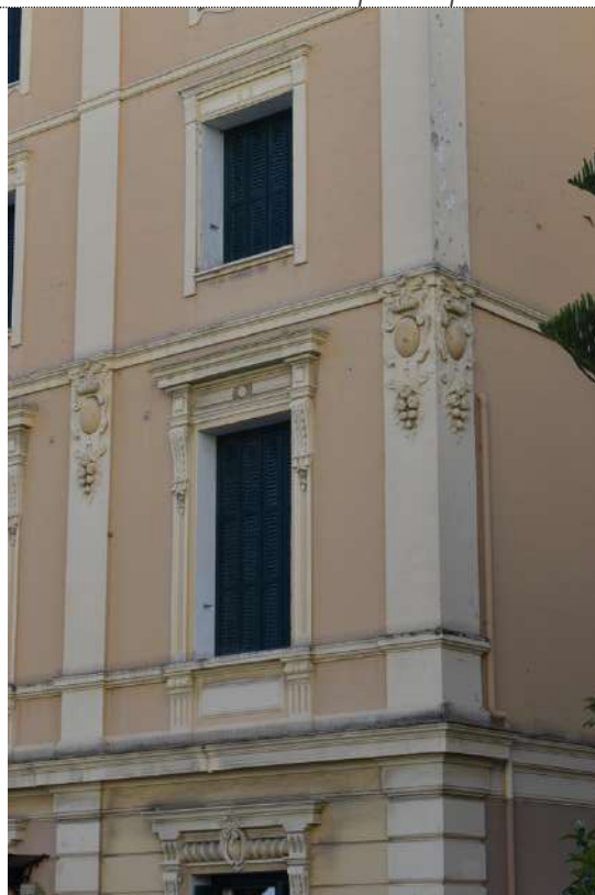
Prospetto Est, angolo nord: particolare della lesena angolare, bugnata a piano terra e liscia con fregi in stucco a piano primo
