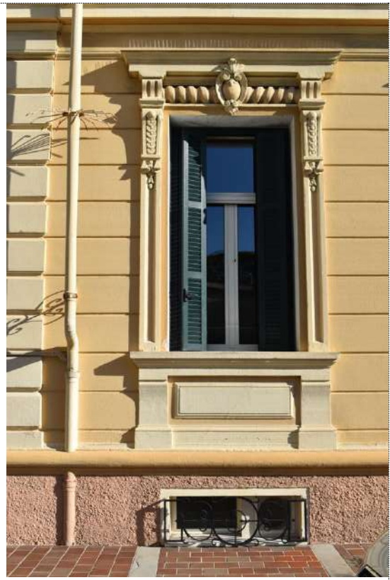
Prospetto Ovest: particolare della cornice in stucco della finestra del piano terra
