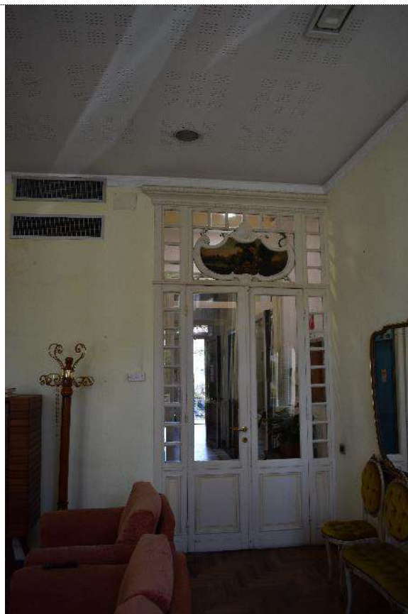
Particolare della porta di accesso dal corridoio al salotto a nord-ovest: vista interna
