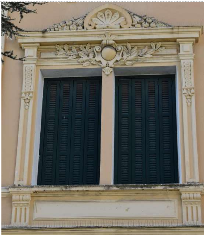
Prospetto Est: particolare del fregio in stucco della bifora del primo piano
