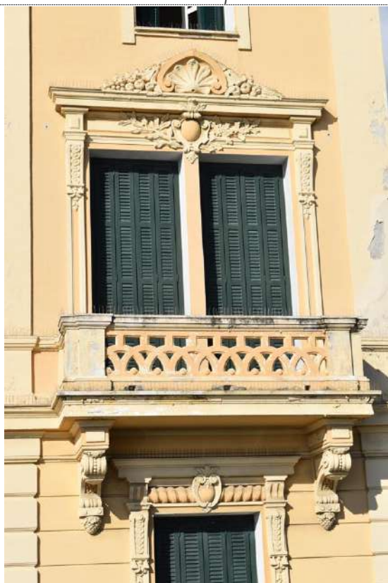
Prospetto Sud: particolare della bifora angolare e del balcone su mensole a piano primo
