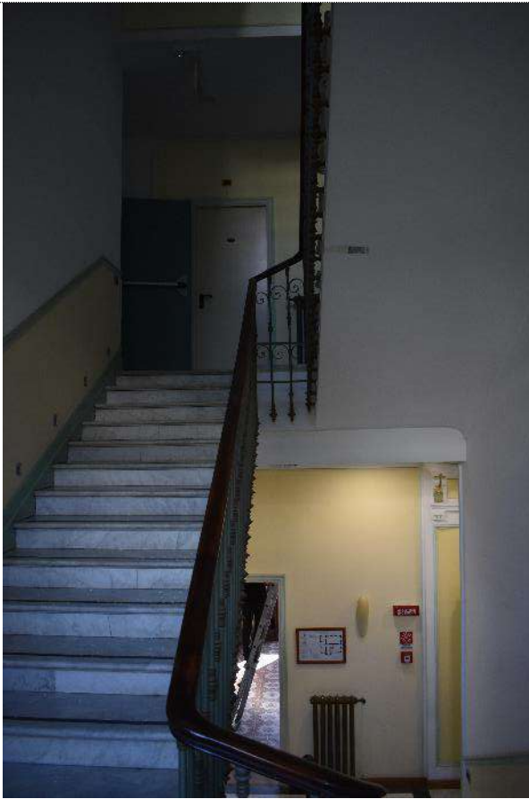
Particolare del vano scale: seconda e terza rampa
