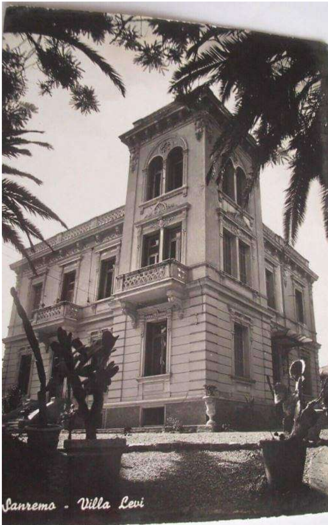
Villa Levi in una cartolina storica risalente al 1940, antecedente alla ristrutturazione edilizia e alla sopraelevazione
