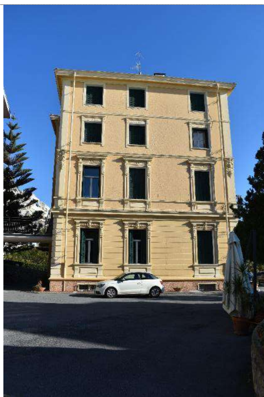
Prospetto Ovest come si presenta oggi dopo la sopraelevazione
