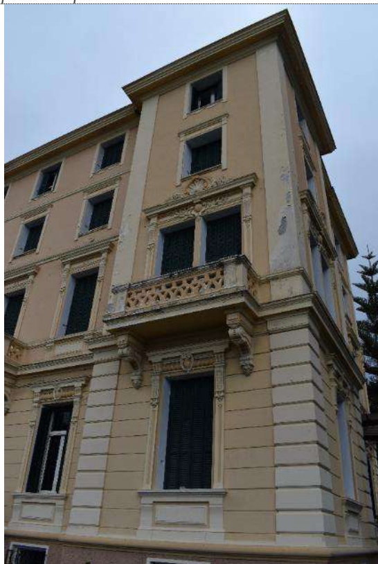
Particolare del fronte sud e della torretta angolare come si presenta oggi dopo la sopraelevazione
