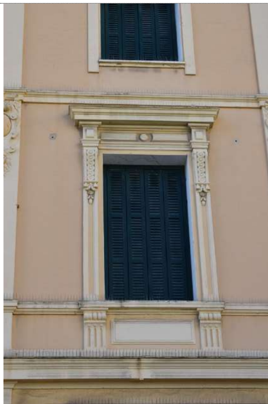
Prospetto Est: particolare della cornice in stucco della finestra del piano primo
