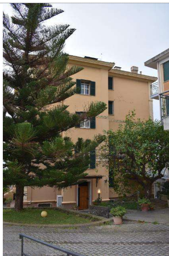
Prospetto Nord come si presenta oggi dopo la sopraelevazione
